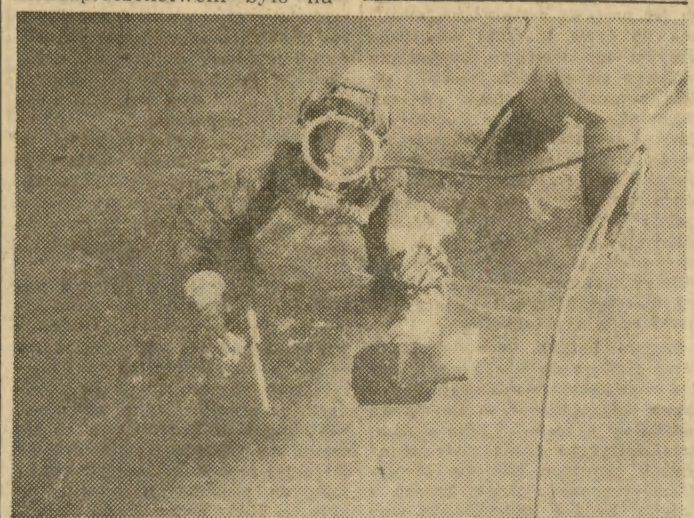
Ostatni sygnał porozumiewawczy z ekipą towarzyszącą i pletwonurkowi W. Kalczyński, specjalizujący się w tego typu pracach podwodnych, rozpoczęcie wycinanie przegród larsenowych.
