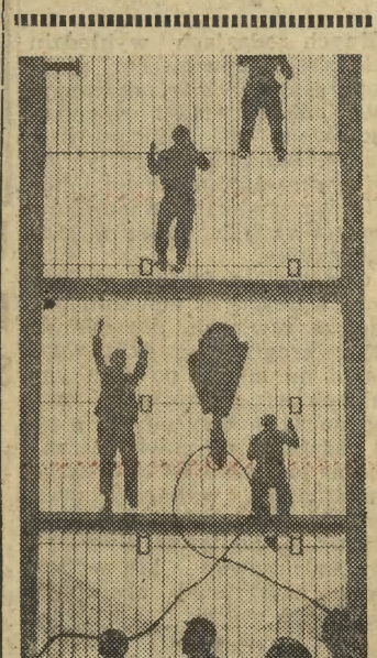
Jak już donosiliśmy, w Żydowie (woj. koszaliński) przekazany został 1,5 km kanał elektryczny przepompowoszczytowej, do którego wpłynęła już woda. N/z: przygotowania do otwarcia śluzy kanału.
