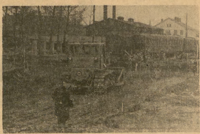
W rejonie Dworca Głównego czynione są przygotowania do planowanej modernizacji ruchu kolejowego — pierwszym etapem prac jest budowa nowej jezdni, która połączy plac dworcowy z ulicą Pawia. Fot. Lech Kleczek
