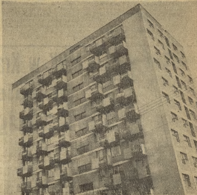
Dom mieszkalny przy ul. Wójtowskiej 9
