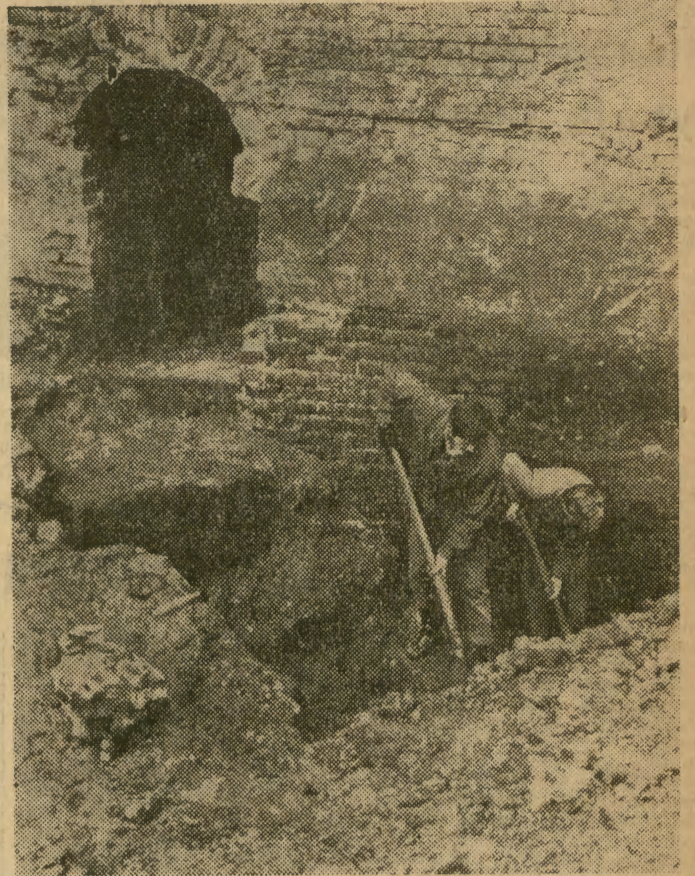
Odsłonięte boczne (wschodnie) wejście do dolnych kondygnacji Barbakanu. Fot. L. Gajer
