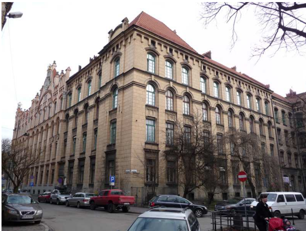
Fot. nr 16 (16-16a). Gmach Technikum Energetycznego z ulicy Loretańskiej 16 – widok spod kościoła Kapucynów. (2012)
