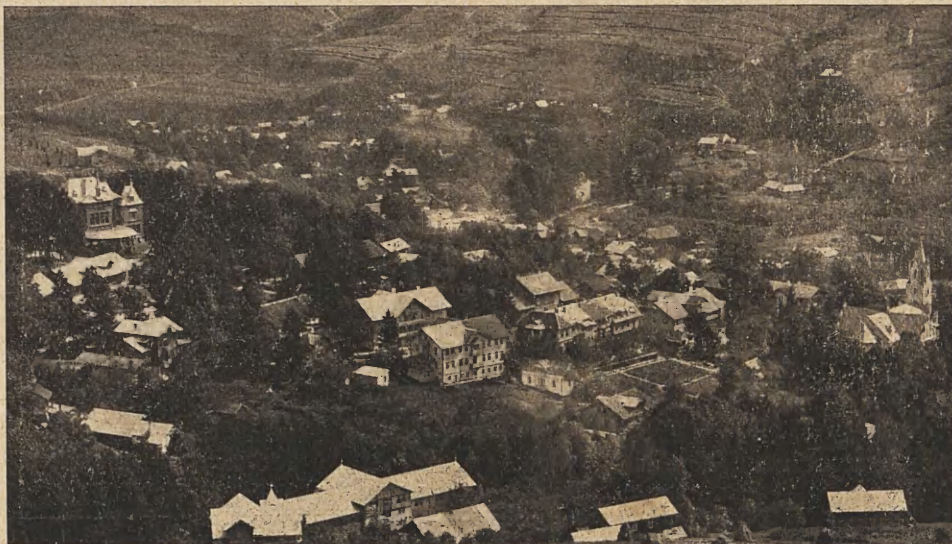
Widok ogólny Szczawnicy.
