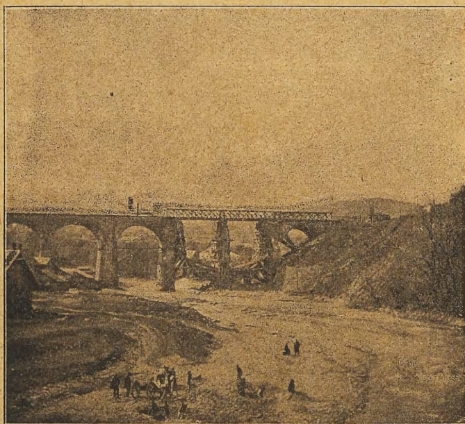
Zniszczony most pod Grybowem po naprawie.
