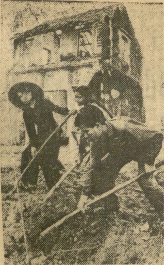
Tysiące dziewcząt i chłopców wietnamskich bierze udział w odbudowie dróg, domów mieszkalnych i fabryk ze zniszczeń, spowodowanych bombardowaniami amerykańskimi. Na zdjęciu: młodzi budowniczy przy pracy w mieście Vinh w DRW. Fot. CAF — TASS
