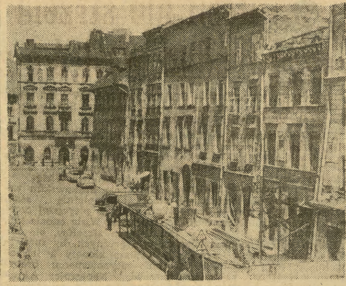
Wielki remont krakowskiej Starówki trwa. Przez wiele jeszcze tygodni będziemy musieli pogodzić się z ustawionymi rusztowaniami, z niewygodnymi przejściami (tak jak to na zdjęciu powyższym przy Małym Rynku) — konserwacja bowiem czy remont zabytkowych kamieniczek to sprawa ani łatwa ani szybka. Fot. W. Pawłowski
