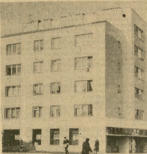
Niewielki budynek „plombowy” na zbiegu ulic Bałuckiego i Zagrody w Dębnikach. Użytkownikiem budynku jest Związkowa Spółdzielnia Mieszkaniowa.
