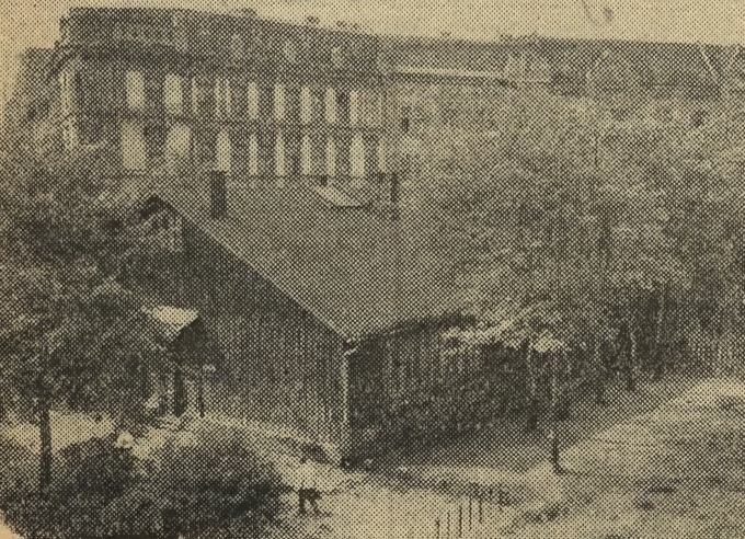
Barak przy ul. Dietla, dawna siedziba szkoły specjalnej, przeniesionej do gmachu Tysiąclecia przy ul. Łagiewnickiej.
