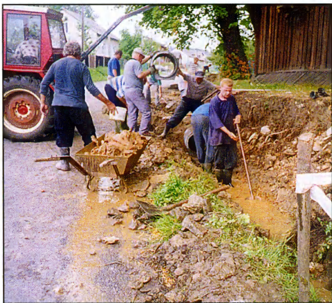
Podczas prac przy kościółku latem 2001r., Foto: Halina Ładoń
