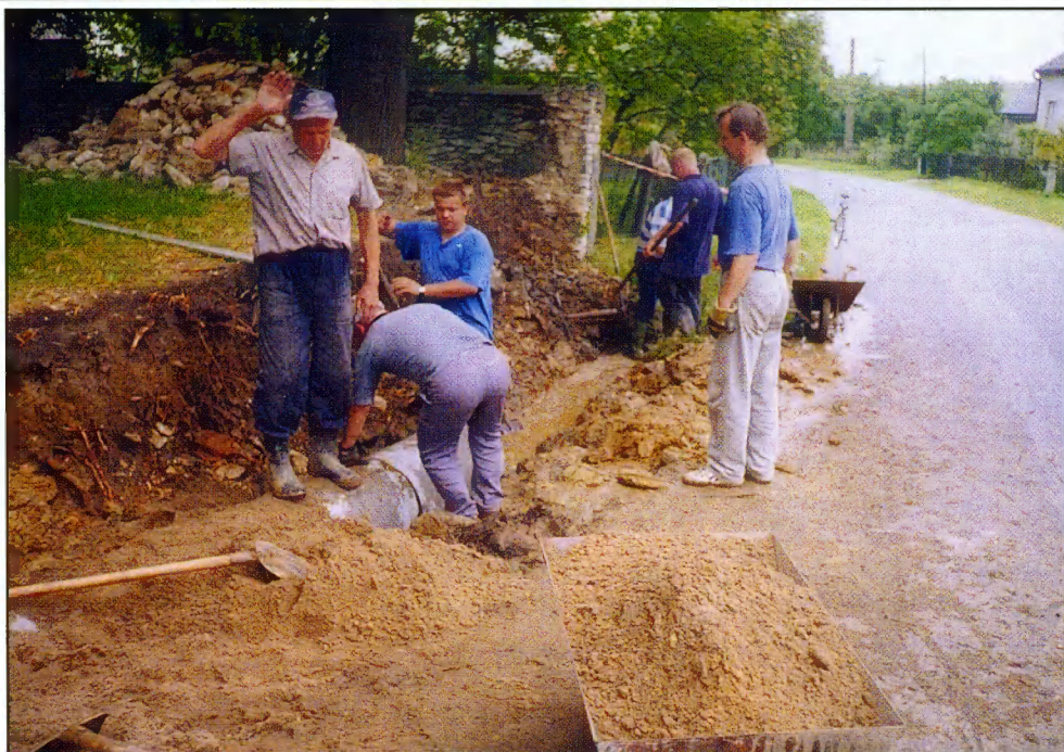
Podczas prac przy kościółku latem 2001r., Foto: Halina Ładoń
