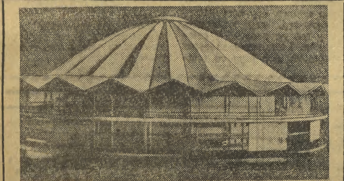
Słynny cyrk moskiewski otrzyma wkrótce nowe, luksusowe pomieszczenie w jednej z południowych dzielnic stolicy. Hala widowiskowa będzie liczyła 3 tysiące miejsc. Rewelacją w tego rodzaju budownictwie będzie betonowa kopuła złożona wyłącznie z elementów prefabrykowanych. (db)
