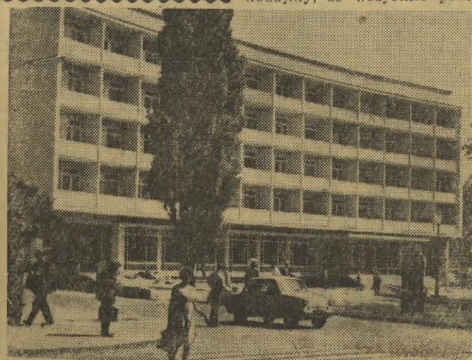
Tak wygląda Dom Turysty od strony frontowej. (Fot. J. Lewicki)
