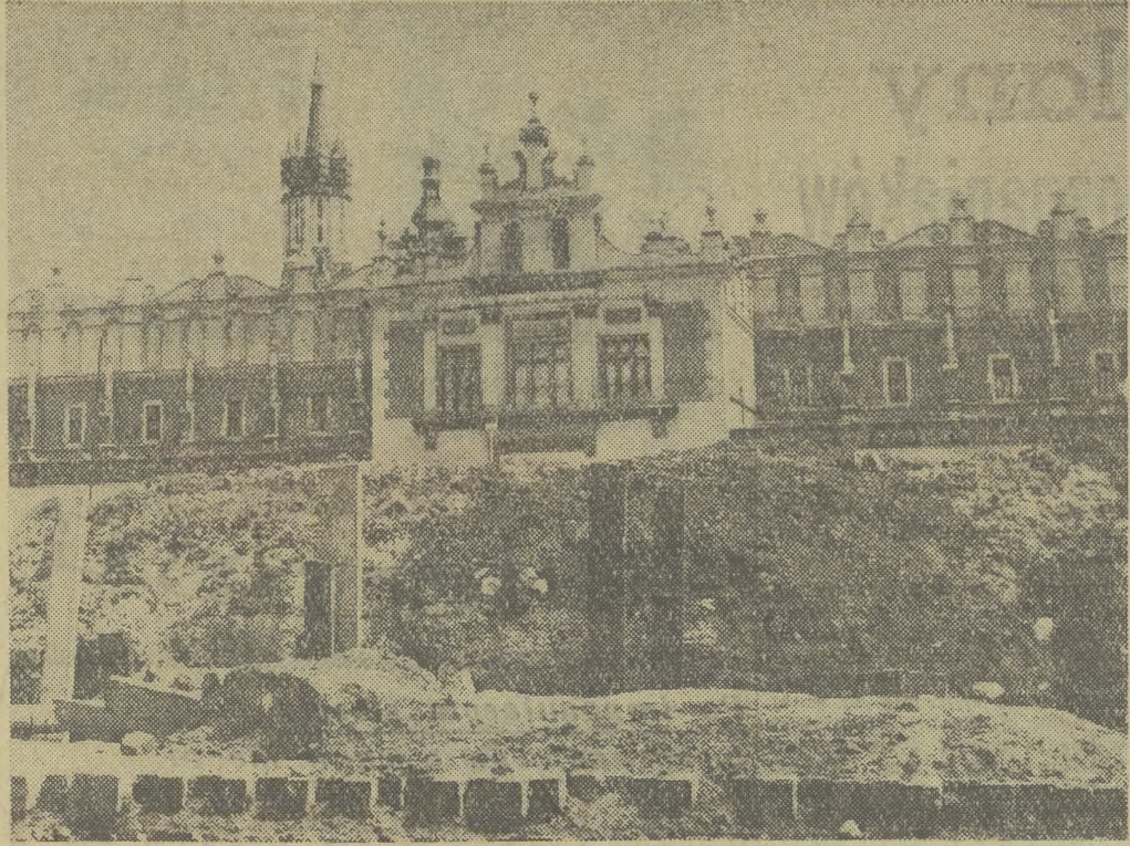
Zza ziemnych wykopów związanych z generalnym remontem Rynku Głównego prawie już nie widać Sukiennic. Fot. J. Lewicki
